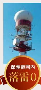
スペイン気象庁の気象レーダーに設置。バスク地方は雷の発生率が高い地域として知られています。dinnteco-100plus設置直前にはレーダーへの直撃雷があり、実証実験期間中も2km圏内で96回の落雷がありましたが、保護範囲内への落雷は、冬季雷含め0件となりました。
