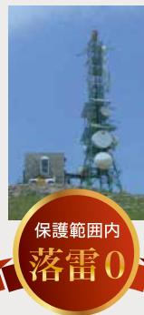
スペイン・ABERTIS TELECOM社所有のマゼラ通信塔に設置。従来は電気・電子部品の損傷を伴う落雷が多発していましたが、dinnteco-100plus設置後は、周辺3km圏内で374回の落雷が発生する中、保護範囲（半径100m）内への落雷は0件という結果となりました。
